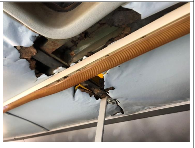
Figura 10 – Forro de teto
