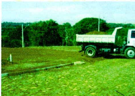
Caçamba para transporte de terras e entulhos.
