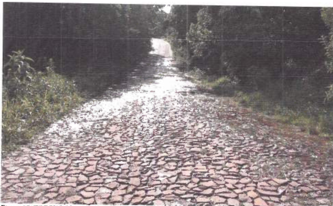
Figura 15: TRECHO 03, pt 11 GPS (bueiro), TRÁS
