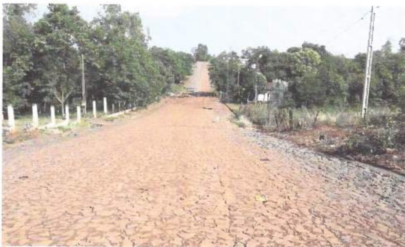
Figura 4: TRECHO 02, final, pr 25 GPS, Marciánópolis (Sede). Entr. TRECHO 02/03. TRÁS
