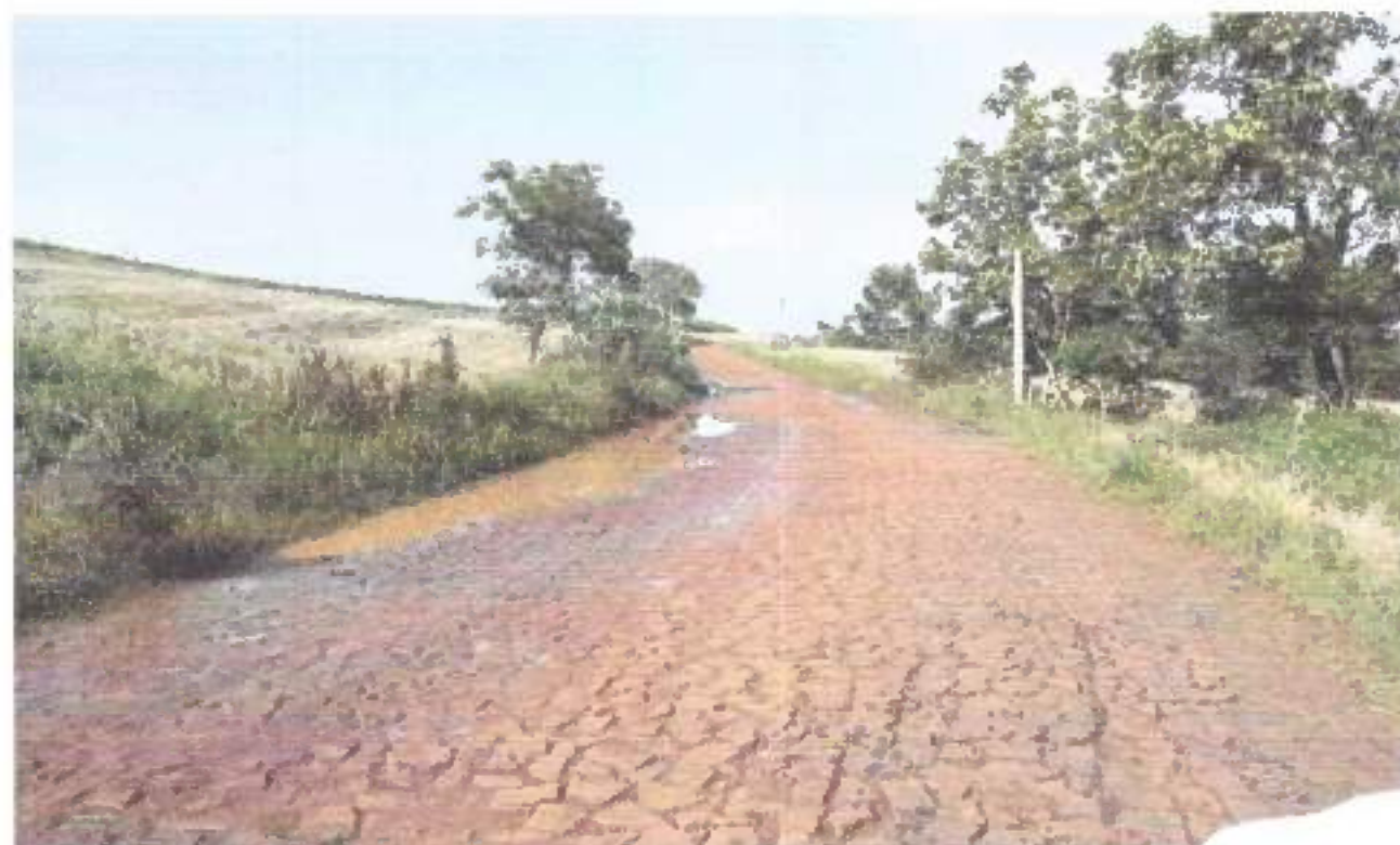
Figura 14: TRECHO 03, pt12 GPS (necessidade de desconfinamento lateral). TRÁS
