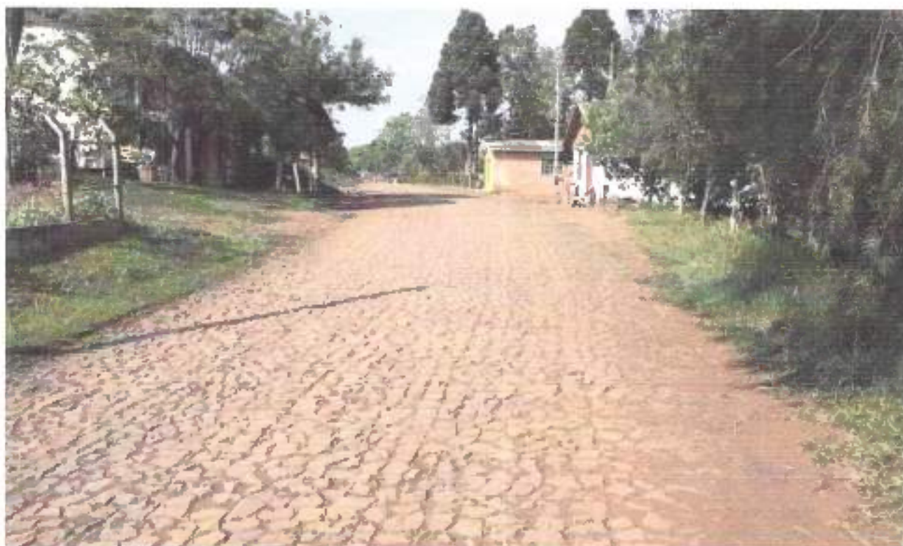
Figura 6: TRECHO 03, pt 23 GPS (ginásio de esportes Maracanópolis). TRÁS
