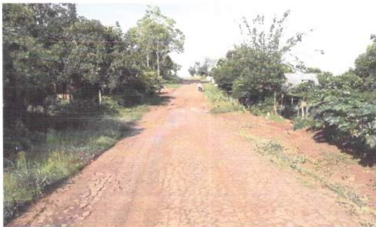
Figura 17: TRECHO 03, pt 04 GPS (dentro Km 13). TRÁS
