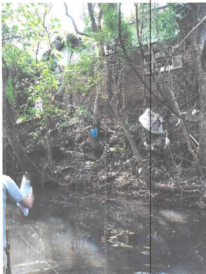
Imagem 05: Edificação na barranca do rio cedro
